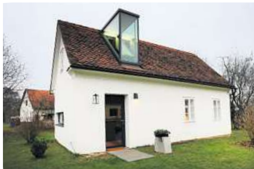
Das Ferienhaus mit sanierten Kastenfenstern ...
