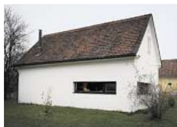
Neues Fensterband in der Küche
