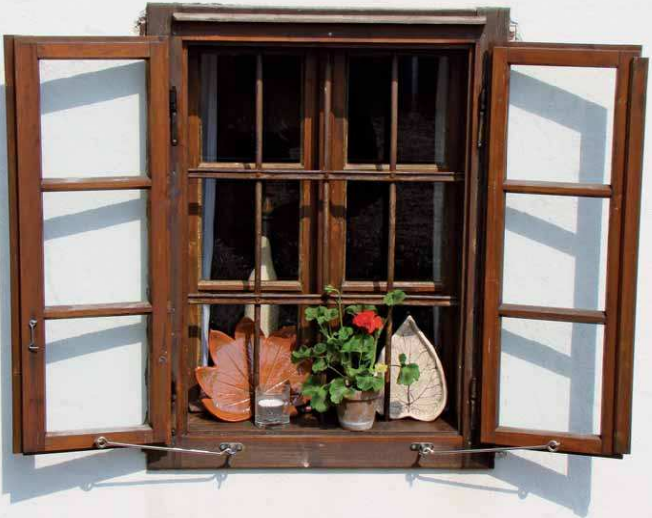
Originalgetreu nachgebaute Kastenfenster im Ferienhaus „Am Lampl Berg“.
